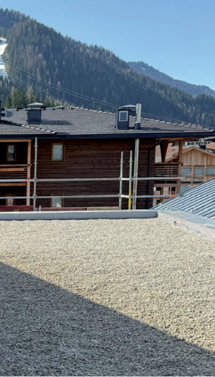
Le tèt dla Ciasa de Cultura a La Ila é gnü sistemé por tò demez les infiltraziuns d'ega che gaujà tres indò de gragn dagns pro le frabicat.
